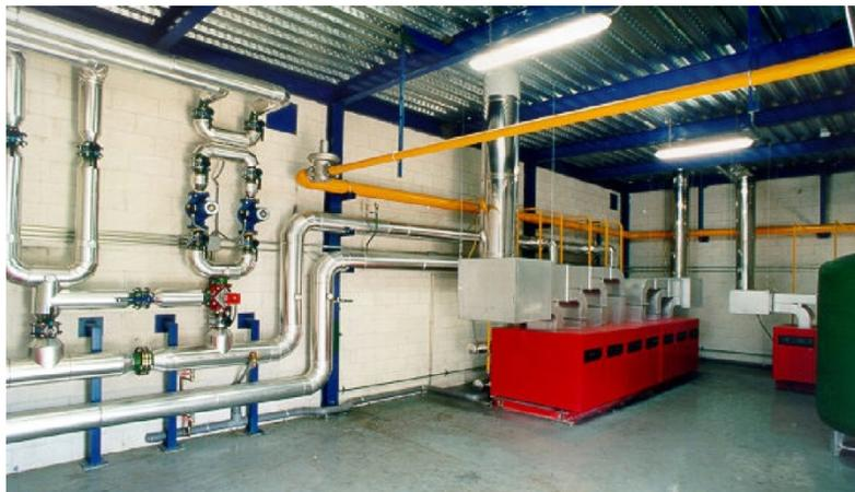
➤ La sustitución de estas calderas por otras de gas natural de máxima eficiencia (condensación o B<sup>a</sup>T<sup>a</sup>) supone alcanzar rendimientos de entre el 95 y 100% con la consiguiente reducción del consumo energético y de emisiones contaminantes.
